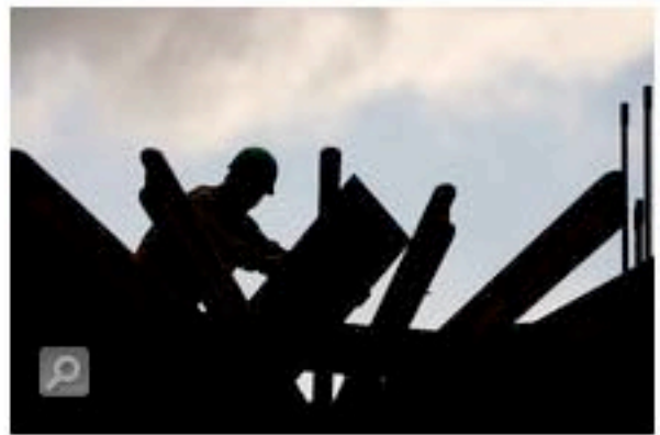
Arbeiter auf einer Baustelle
